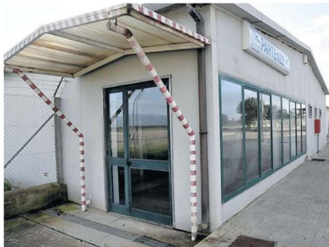
Uno dei locali dell'aeroporto di Fenosu
